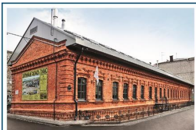
Волгоград | ЛОФТ1890, здание XIX века, объект культурного наследия регионального значения «Жигулёвские пивные склады» | Регуляторы давления газа в составе подземного ГРП
